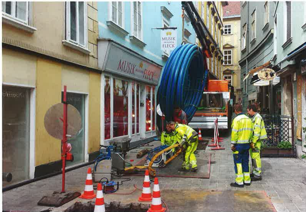
Wasserleitungs- und Kanalnetzsaniierungen im Altstadtbereich stellen die Unternehmen oft vor Herausforderungen.
